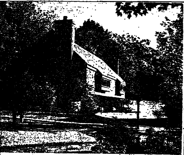
Actual photo of Cluster Homes.
